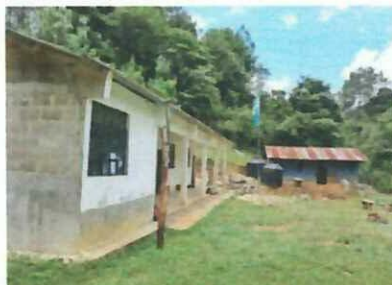
Foto 5: Depósitos de agua mal ubicados, se necesita ubicarlos en un lugar adecuado para que el agua se distribuya correctamente en los lugares necesarios del establecimiento por ejemplo la cocina y los baños.
